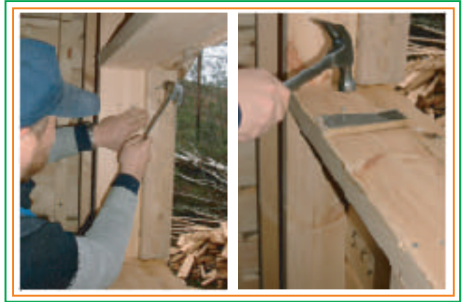
2. Asennetaan topparit ikkunalle ja rivevarat alapuun päälle.
