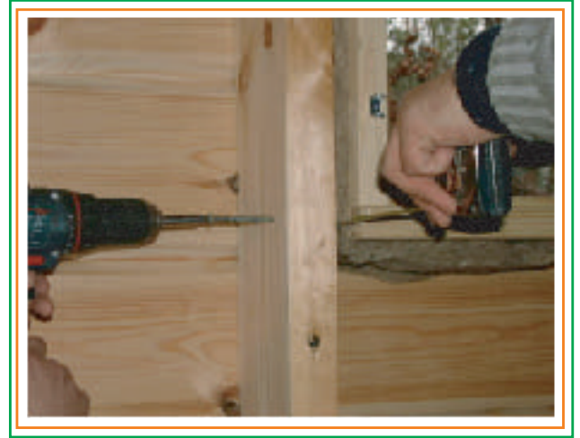
8. Pienet ikkunat ja tuuletusluukut voidaan kiinnittää ruuveilla rungon takapuolelta, jolloin säästetään ruuvireikien tulppaamiselta.
