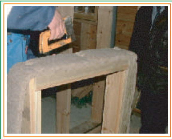
3. Kiinnitetään ISOLINA-pellavaeriste karmin päälle nitomalla.
