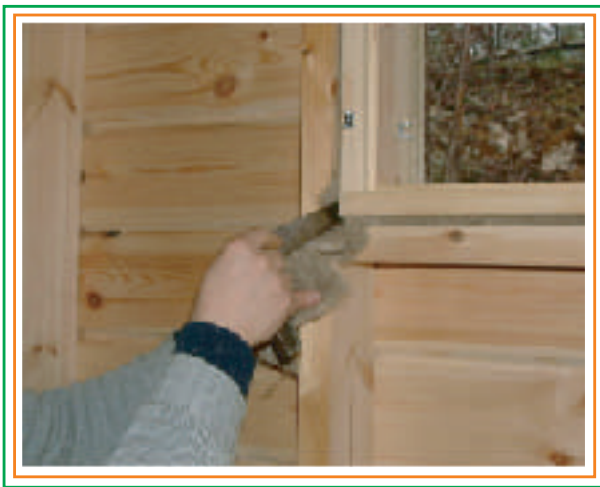
9. Tarkistetaan riveys ikkunan kulmissa.
