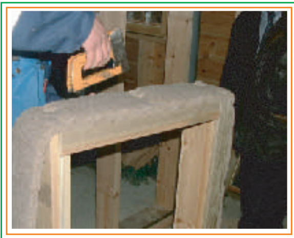
3. Kiinnitetään ISOLINA-pellavaeriste karmin päälle nitomalla.
