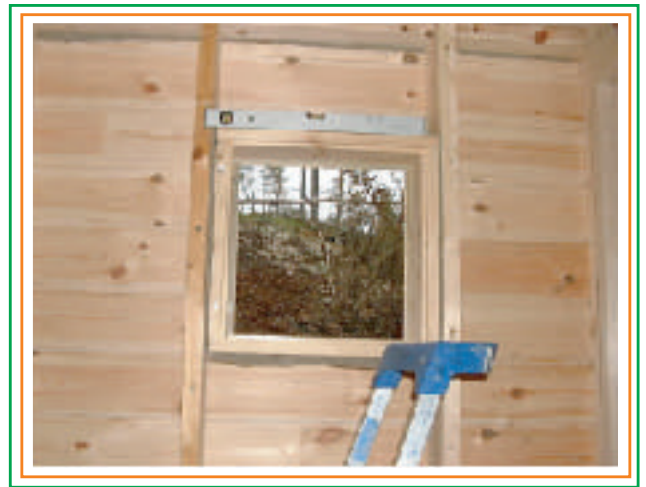
10. Kapeissa ikkuna-aukoissa aukon ylä- ja alapuu ei ole välttämätön.
