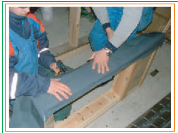
4. Kiristetään ISOLINA-pellavaeriste muovikaistan avulla. Nidotaan muovikaista karmin reunoihin.
