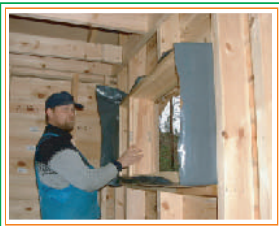
5. Asennetaan ikkuna paikoilleen.
