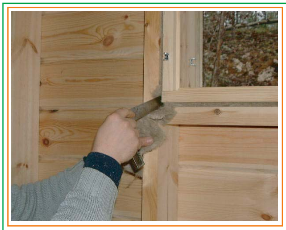
9. Проверьте уплотнение в углах окна.
