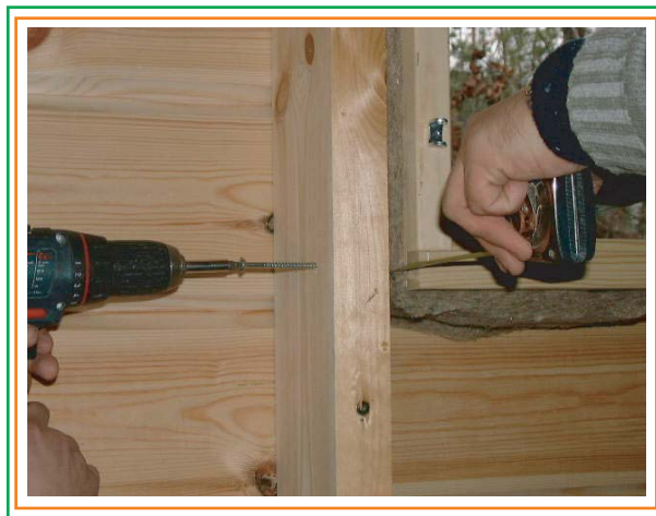
8. Небольшие окна и вентиляционные ставни можно зафиксировать при помощи шурупов-саморезов с тыльной части бруса оконного проёма.
