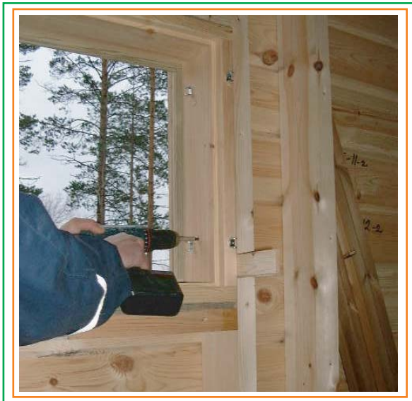
7. Приверните шурупами оконную раму к оконному проёму.
