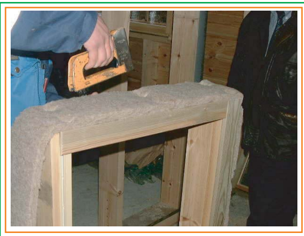
3. Fäster ISOLINA-linisolering på fönsterkarmen med nitpistol.
