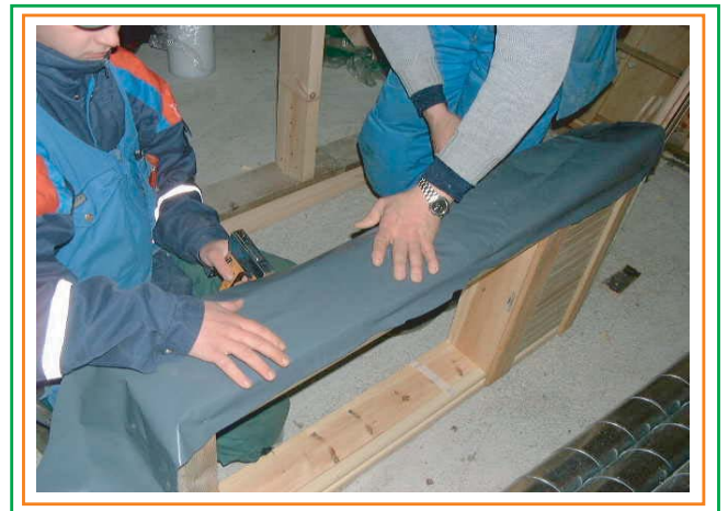
4. Spänner åt ISOLINA-linisolering med plastremsa. Nitar fast plastremsan på fönsterkarmens sidor.
