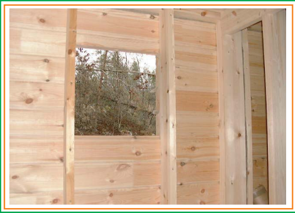
1. Man gör ett fönsterhål i stommet.
