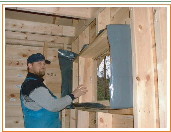
5. Installerar fönstret på plats.
