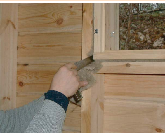
9. Kontrollerar tätningen på fönstrets hörn.
