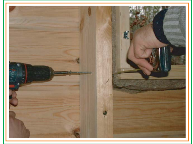
8. Små fönster och ventilationsluckor kan fästas med skruvar från stommets bakdel.
