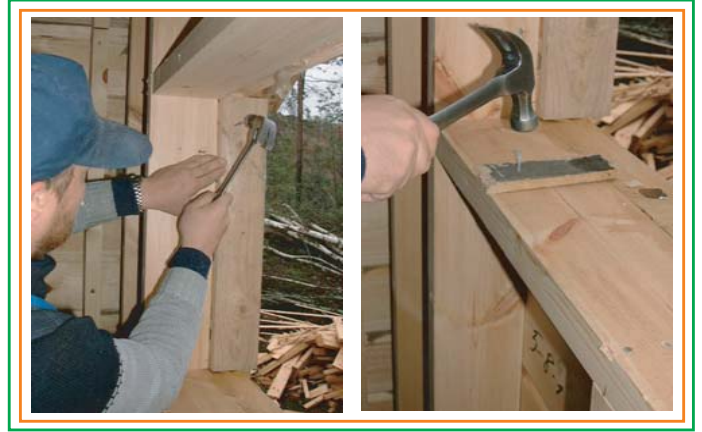
2. Installerar stoppare på fönstret och tättningsreserv på underregeln.
