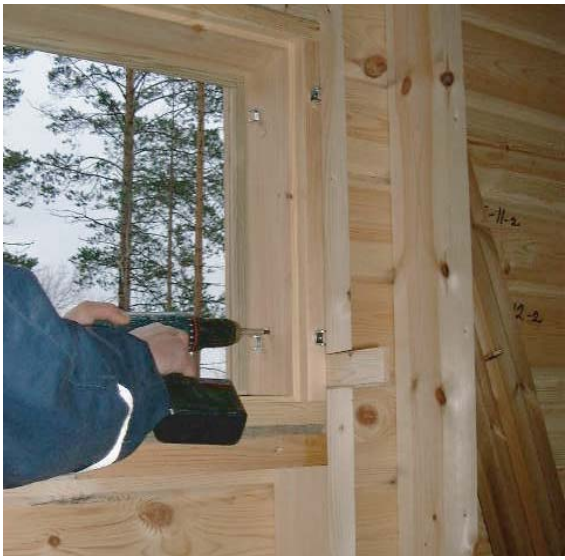
7. Fäster fast fönsterkarmen med skruvar.
